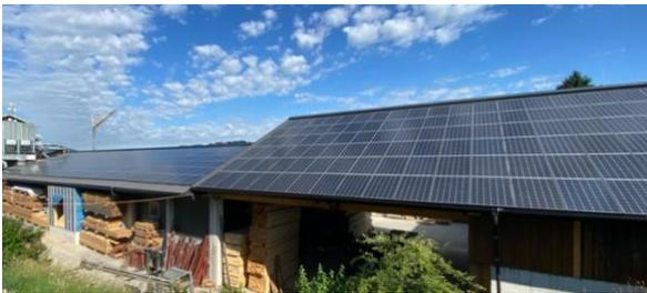
1500 Quadratmeter Dachfläche wurden mit der Photovoltaikanlage verbaut. Die Schobergruppe gewinnt daraus jährlich 140.000 kWh Strom.
